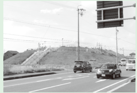
【袋井市：「湊 命山」】 敷地面積 6,433㎡ 盛り土天端部分面積 1,300㎡ 収容人員 1,300人
