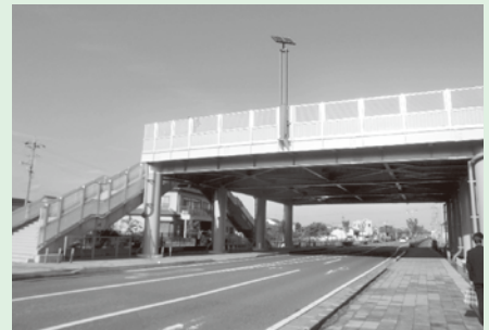
【吉田町：津波避難タワー（歩道橋型）】 延面積 628㎡ 収容人数 1,200人
