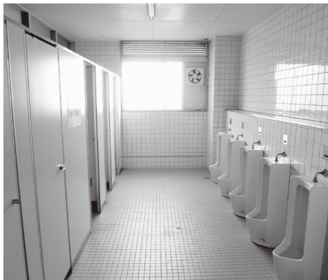
木曾岬小学校児童用トイレの現況
