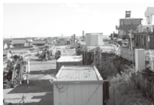
木曾川左岸耐震補強工事現場(源緑輪中地先)
