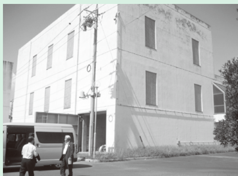
(鍋田川下流排水機場 外観)
