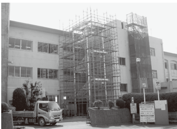
施工が進む木曾岬小学校外付け屋上避難階段
