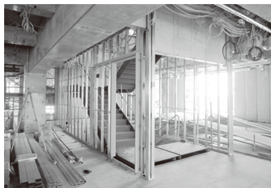
行政棟2F 東側階段付近→
