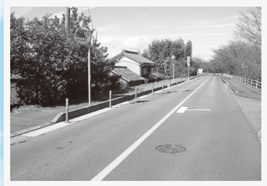
町道鍋田川線舗装工事 約4100万円
