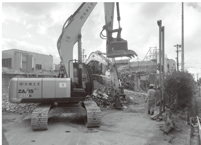
旧庁舎解体の様子→
