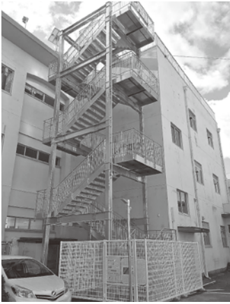
設置が完了した 小学校屋上への外付け避難階段
