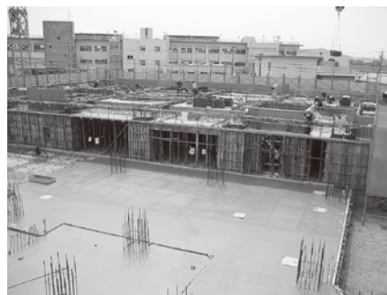
複合型施設建設工事 施工状況
