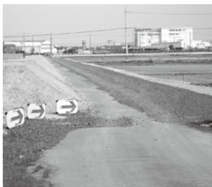
町道雁ヶ地・福崎線 延伸道路拡幅
