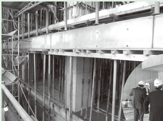
3階の打設状況
