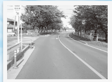
町道鍋田川線舗装工事 約4,700万円
