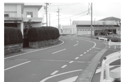
町道田代・小学校線道路改良工事
