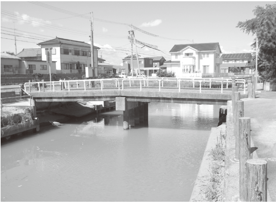
点検を行った橋
