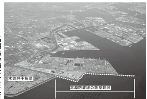
高潮防波堤改良箇所
