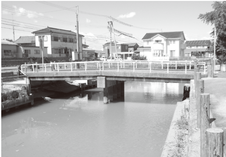
修繕工事を予定する小林橋
