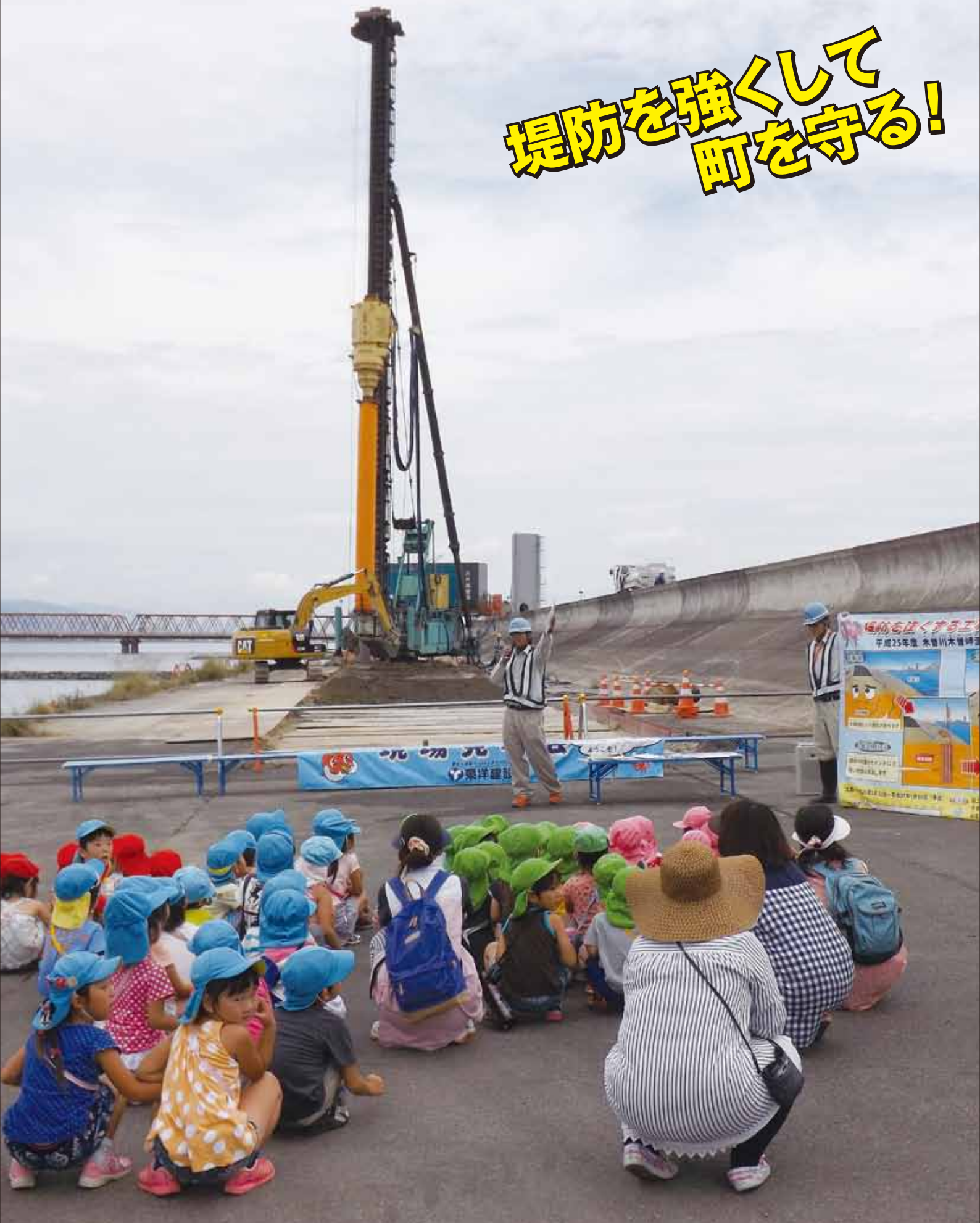
【写真】 木曾川木曾岬源緑高潮堤防補強工事 南部幼稚園・保育園見学会より
