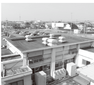
給食センター屋上(現況写真)
