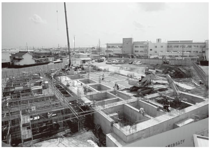
行政棟の地中梁が完成し→埋戻し状況写真
