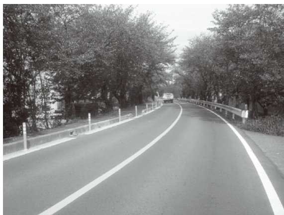
設置されているラバーポール
