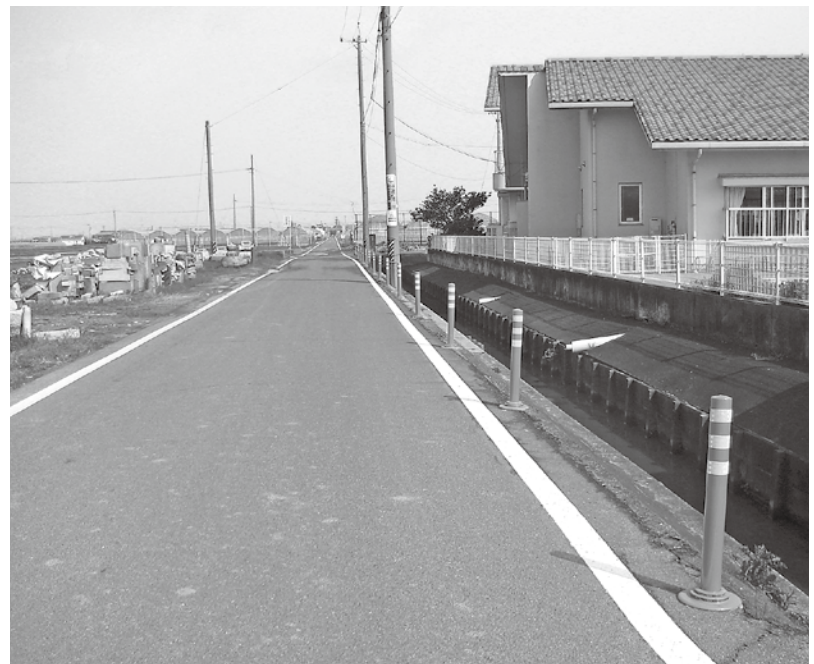
道路安全対策状況
