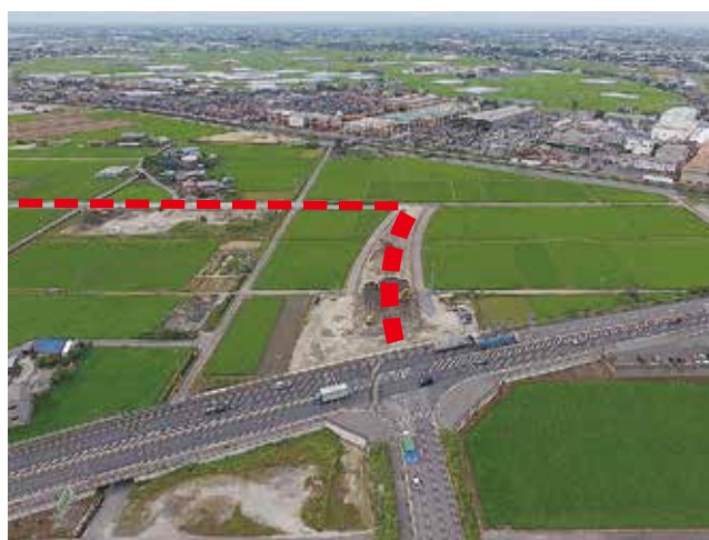
町内を結び木曾岬干拓地との交通の要となるバイパス
