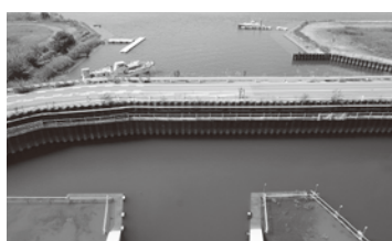
機械室からの木曾川
