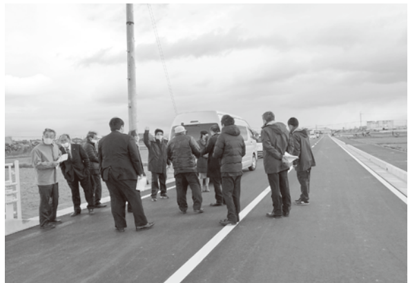
町道雁ヶ地・福崎線道路改良工事
