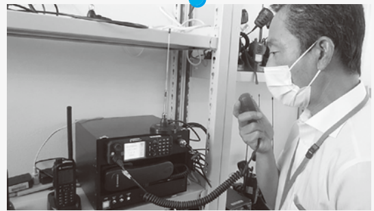
防災行政無線デジタル化更新工事 3,894万円
