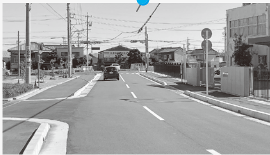
町道田代小学校線避難路整備工事 8,823万円
