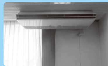
北部公民館第1会議室エアコン修繕
