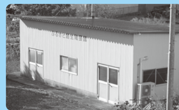
ふるさと陶芸館屋根修繕
