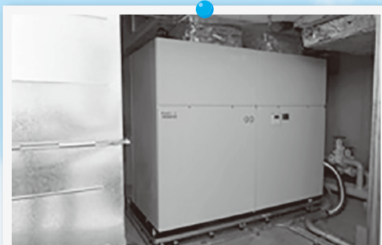
①木曾岬町体育館空調設備改修工事 4,023万円
