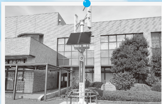
③災害時対応夜間照明灯設置工事 556万円
