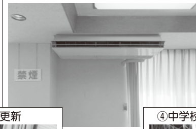
③北部公民館2階空調設備更新
