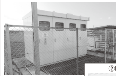
①町体育館高圧受電設備更新
