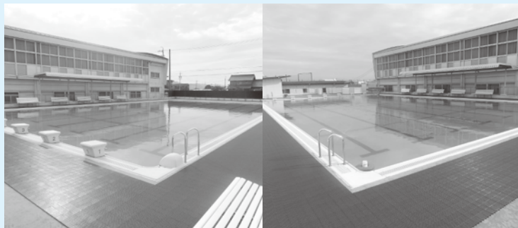
中学校プールサイドマット敷設後
