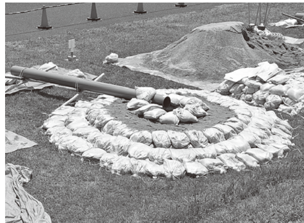
完成した釜段工
