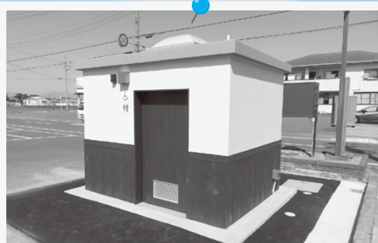
③公共施設トイレ改修工事(町体育館外) 7,867万円
