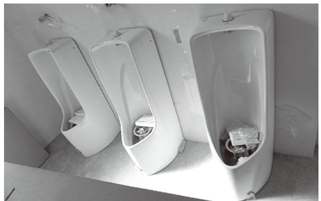
木曾岬小学校外トイレ
