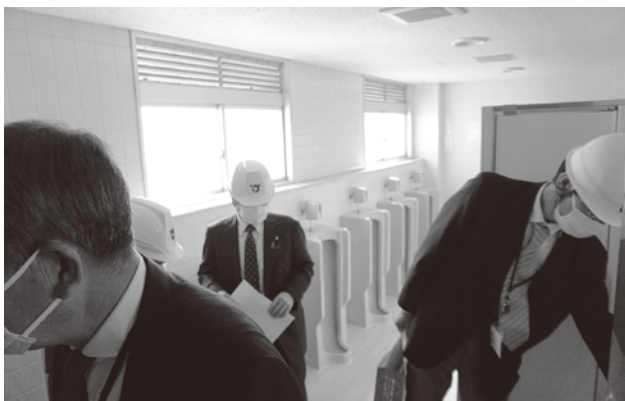
町体育館内トイレ
