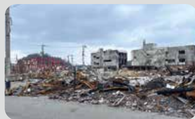
輪島朝市火災跡
