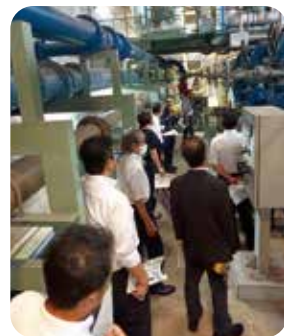
地下の配管・設備類を視察
