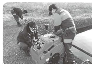
機械器具の点検
